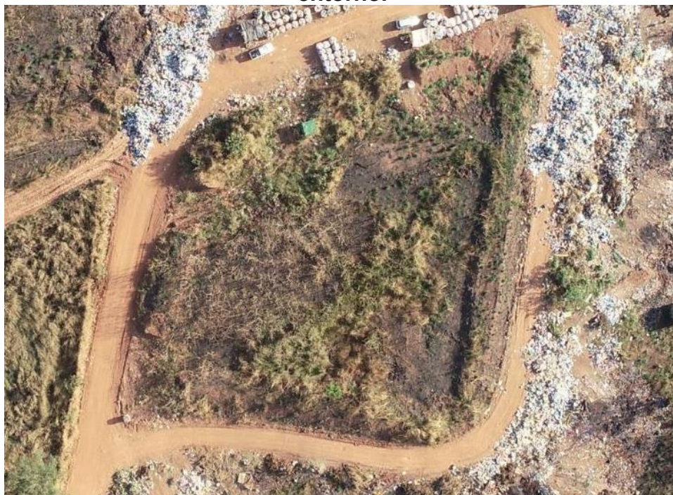
Figura 58 – Vista aérea da trincheira do aterro sanitário encerrada e resíduos no entorno.
