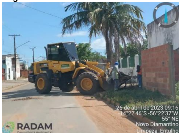
Figura 36 – Coleta de Volumosos e RCC
