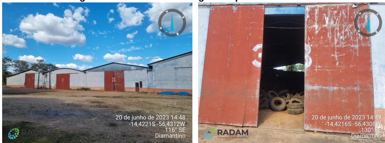
Figura 43 – Local de estocagem de pneus inservíveis.
